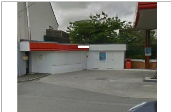
Vue d'ensemble de la station essence
