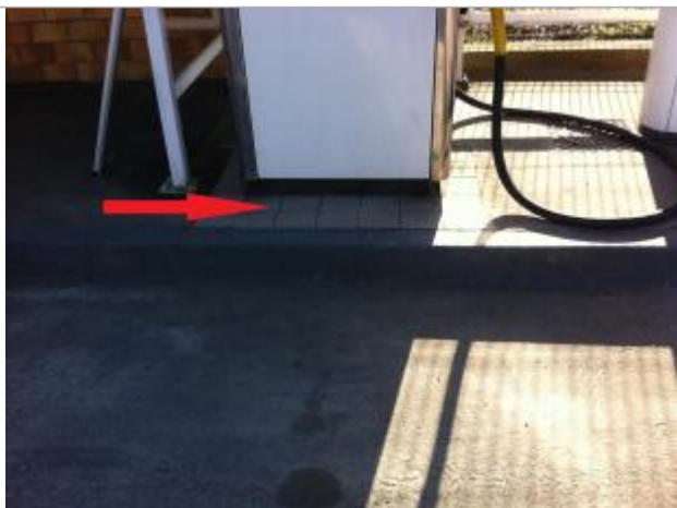
Partie carrelée au niveau de la pompe
