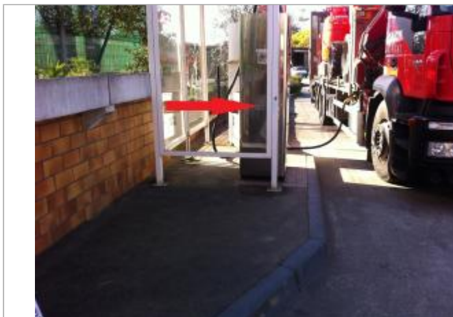
Cuve à gazoil de la station essence
