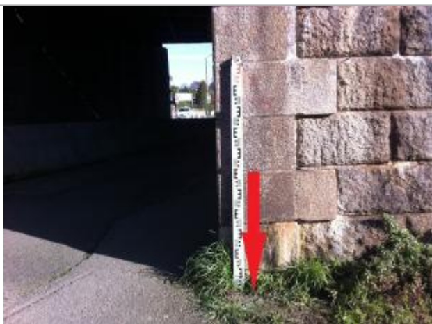
Sol au droit de la pile
