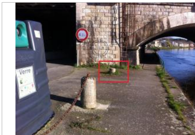
Quai en amont du pont SNCF - 1ère borne d'amarrage
