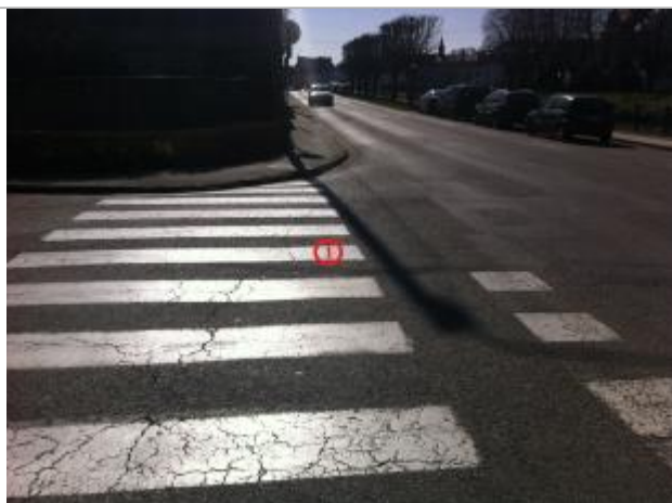
Sol / passage piéton
