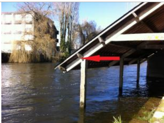
Toit du lavoir
