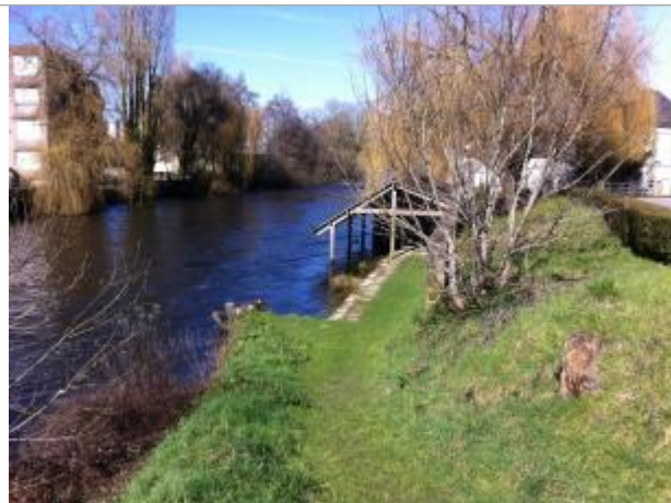
Vue d'ensemble de l'ancien lavoir
