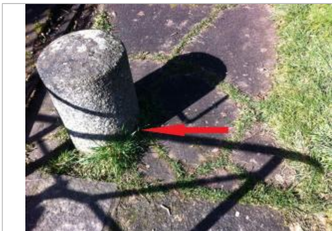
LIMITE AU POTEAU BETON (pied côté rivière)
