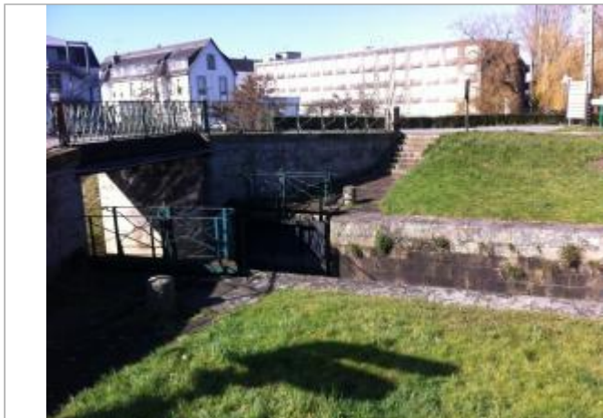
ECLUSE DU QUAI DES RECOLLETS
