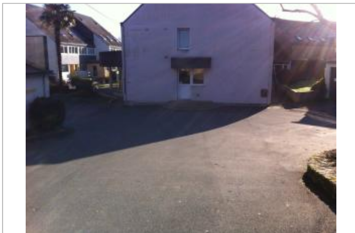
Facade du bâtiment
