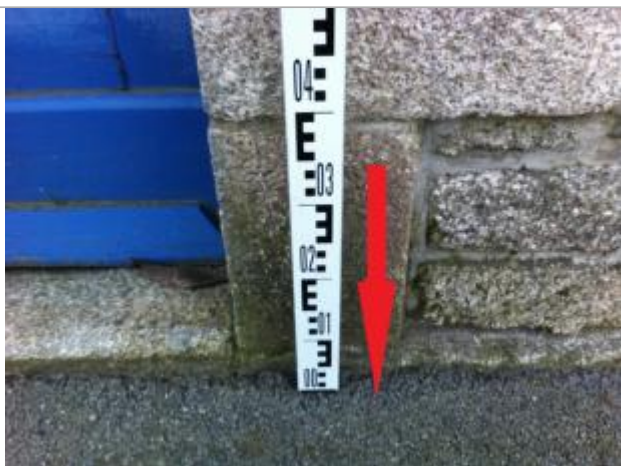
Sol au droit du mur (à proximité de la porte bleue).
