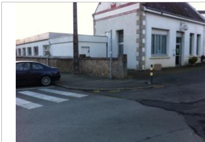
Mur d'entrée de PONTIVY Communauté 1 RUE DES MOULINS
