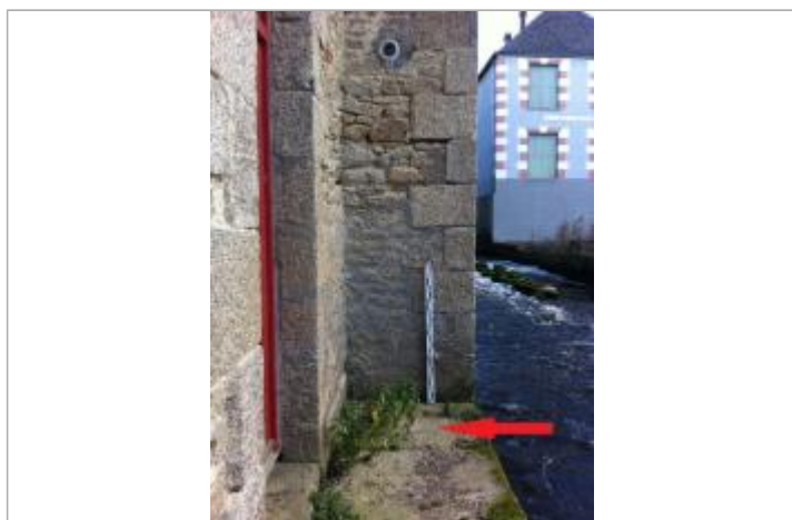
Sol au droit du mur.
