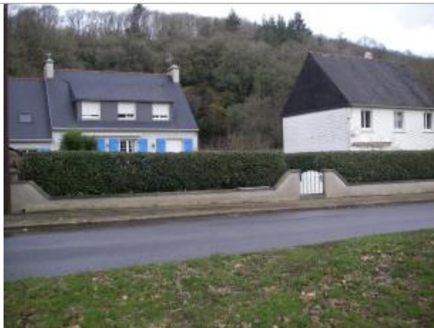
Facade du bâtiment d'habitation
