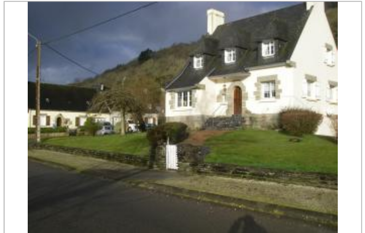
Facade du bâtiment d'habitation
