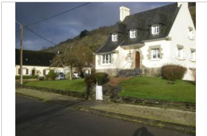
Facade du bâtiment d'habitation
