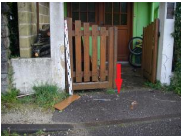
Sol au pied de la barrière
