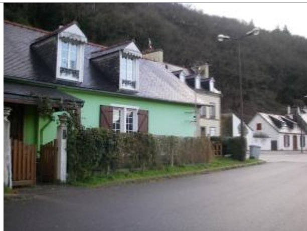
Facade du bâtiment d'habitation
