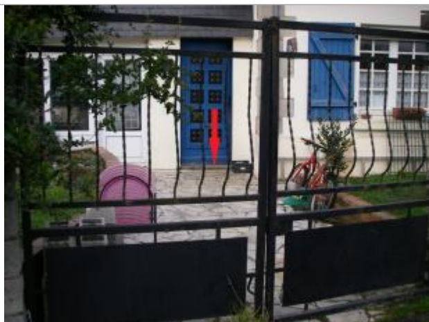
Seuil de la porte d'entrée de l'habitation
