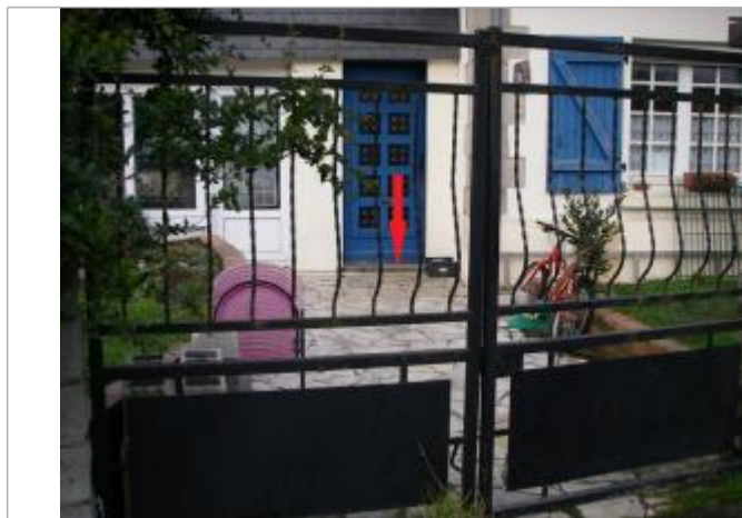
Seuil de la porte d'entrée de l'habitation
