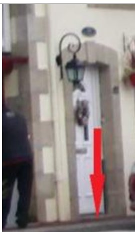
Sol du trottoir au droit de la porte de l'habitation
