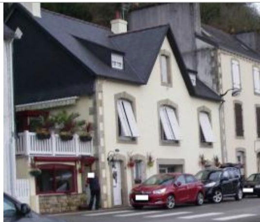
Vue d'ensemble de la façade du bâtiment d'habitation
