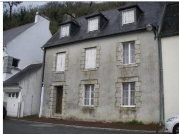
Facade du bâtiment d'habitation
