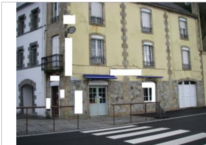
Vue d'ensemble de la façade du bâtiment
