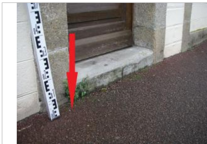
Sol du trottoir au droit de la porte de l'habitation
