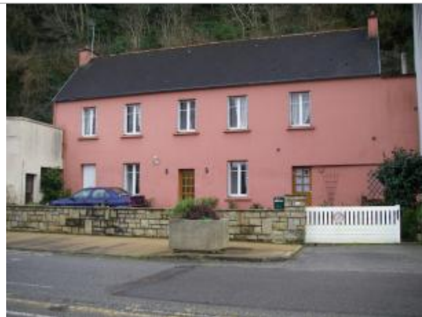
Facade du bâtiment d'habitation
