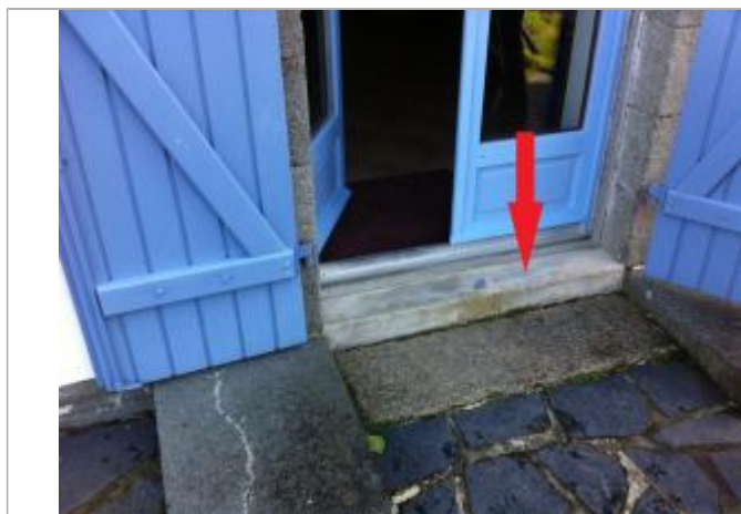
Seuil de la porte-fenêtre.
