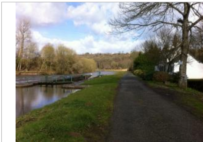
Vue d'ensemble de la maison de l'écluse
