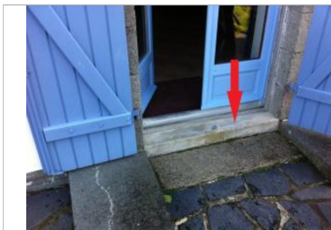
Seuil de la porte-fenêtre.
