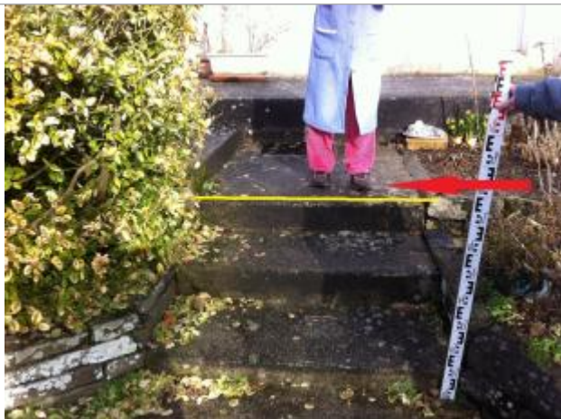
Escalier donnant accès à la terrasse de l'habitation
