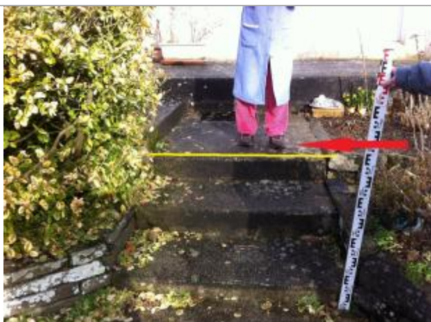
Grande marche de l'escalier donnant accès à la terrasse
