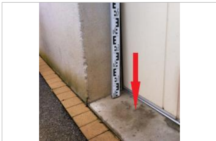
Seuil du garage
