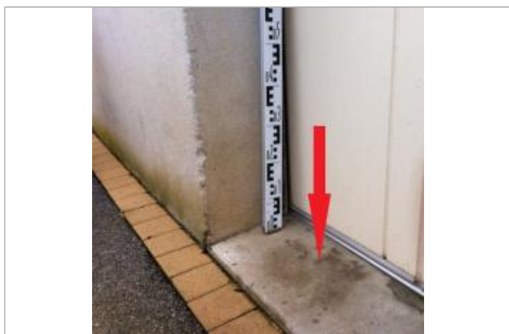
Seuil du garage
