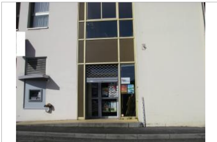
Vue d'ensemble de la façade du bâtiment
