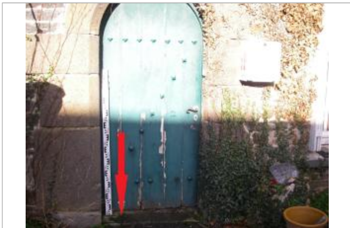
Marche du seuil de la porte d'entrée de l'habitation
