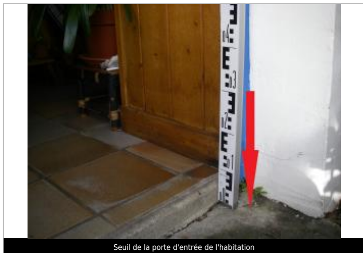
Seuil de la porte d'entrée de l'habitation
