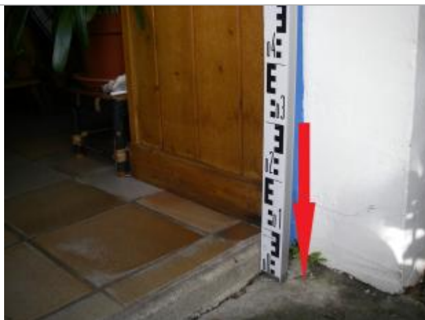
Seuil de la porte d'entrée de l'habitation
