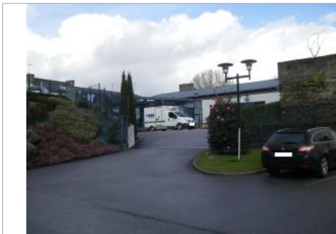
Vue d'ensemble du parking visiteur de la société
