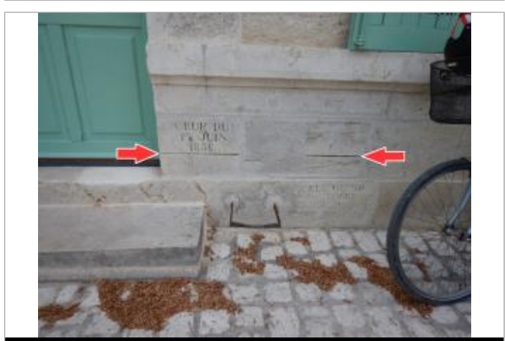
Repère "CRUE DU 1er JUIN 1856" en bon état à gauche et repère "CRUE 1856" abîmé, en 2019
