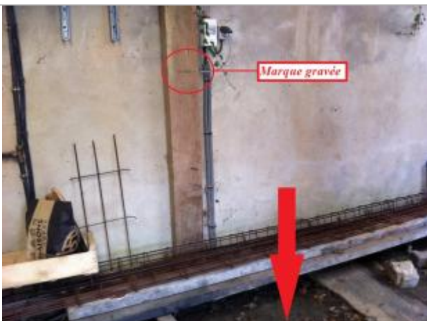
Intérieur du bâtiment
