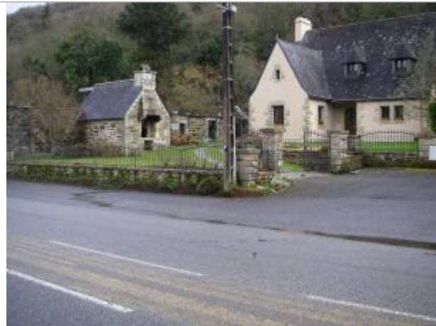
Vue d'ensemble de l'habitation où se trouve les repères
