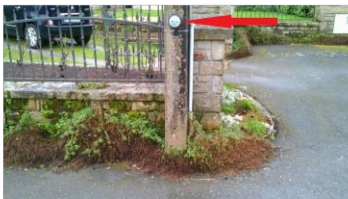
Repère normalisé de la crue du 13 décembre 2000
