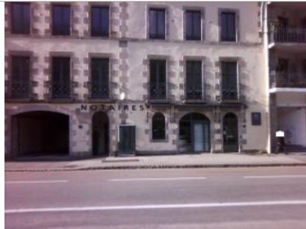
Vue d'ensemble de la façade de l'office notarial
