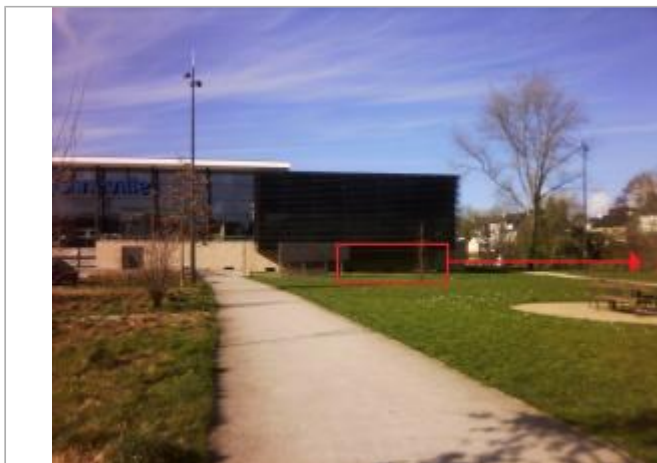
Vue d'ensemble de la façade du bâtiment
