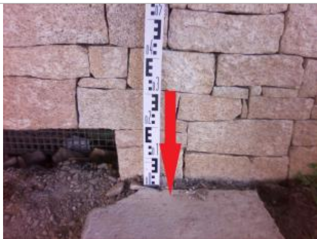
Dalle en béton 0,5 x 1,50 face au mur
