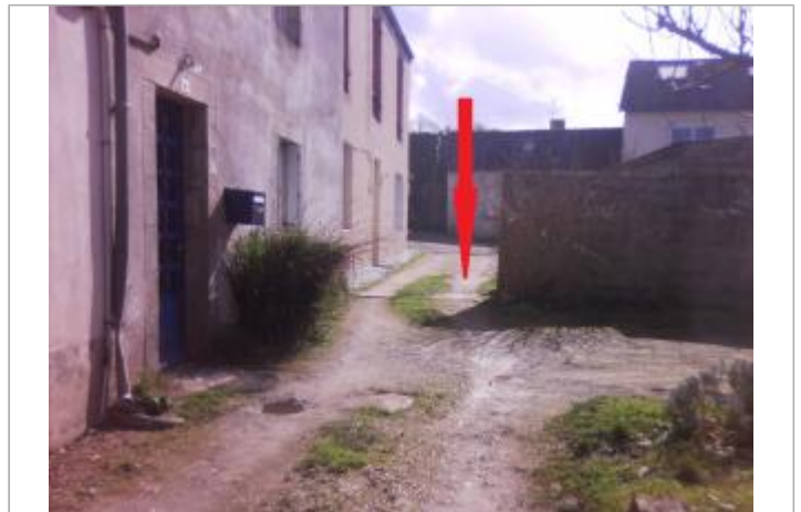
Vue d'ensemble de la façade du bâtiment d'habitation
