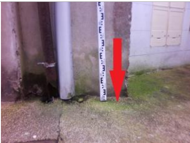
Sol du trottoir à l'arête du bâtiment
