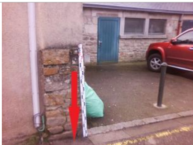
Vue d'ensemble du côté gauche du parking
