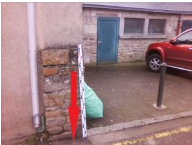
Vue d'ensemble du côté gauche du parking
