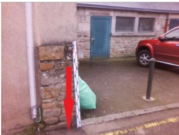
Vue d'ensemble du côté gauche du parking
