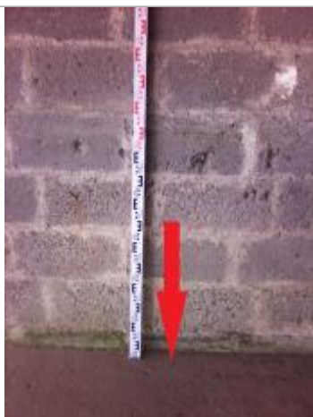
Sol du garage sous le préau
