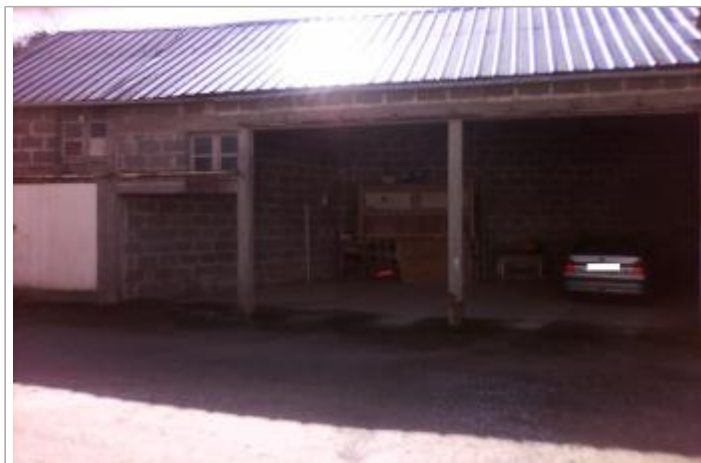
Vue d'ensemble du préau / garage de l'habitation
