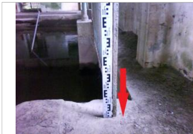
Sol entourant le bassin au fond de la salle (côté opposé à la grille d'entrée)
