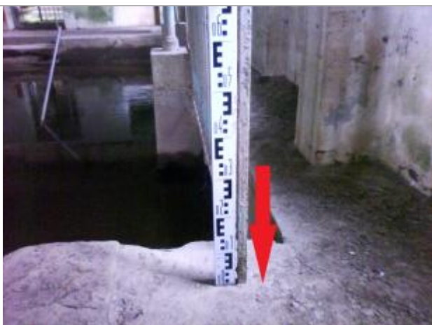
Sol entourant le bassin au fond de la salle (côté opposé à la grille d'entrée)
