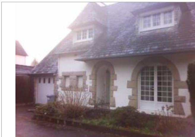
Facade du bâtiment d'habitation
