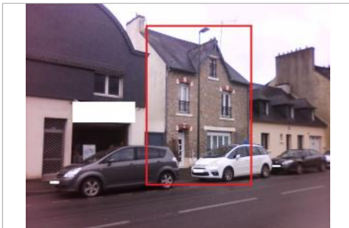
Vue d'ensemble de la façade du bâtiment d'habitation
