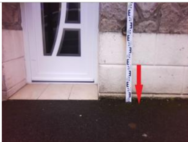
Seuil extérieur de la porte d'entrée du bâtiment
